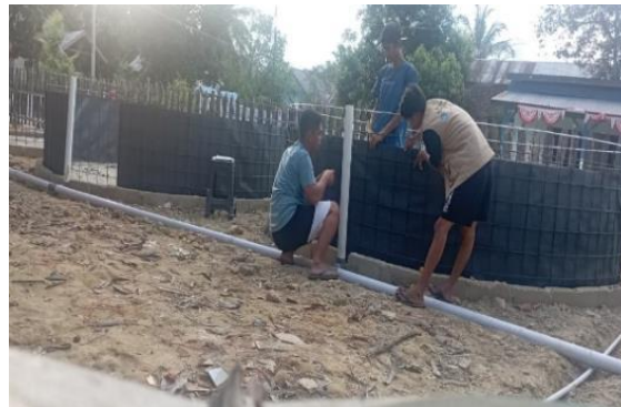
Gambar 2. Pemasangan terpal dan instalasi air
