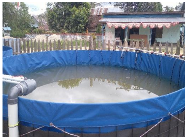
Gambar 3. Pemasangan terpal dan instalasi air pada kolam budidaya ikan air tawar
