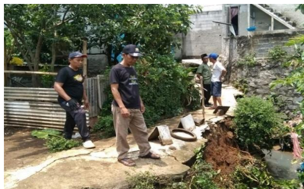
Gambar 1. Kondisi Jembatan Eksisting
