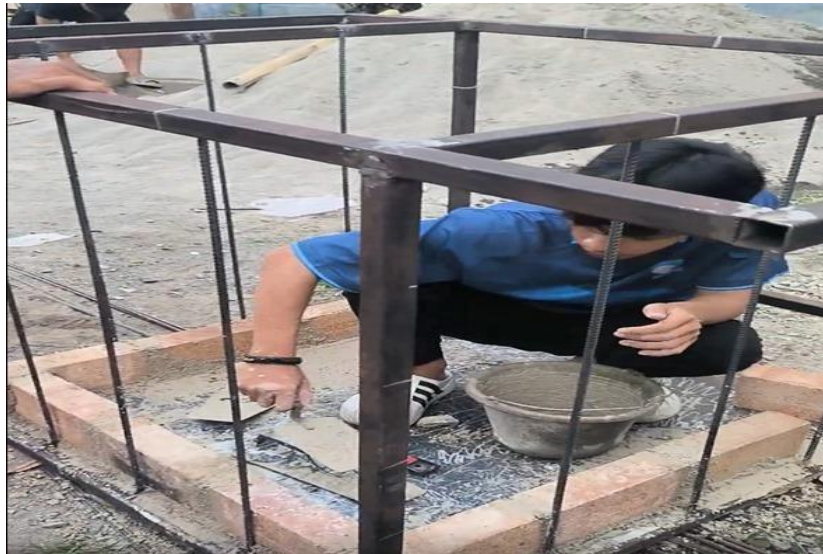
Gambar 6. Pemasangan Fire Brick Ke Dalam Bodi Sebagai Alas Ruang Pembakaran
