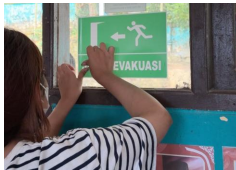
Gambar 1. Pemasangan Safety Sign
