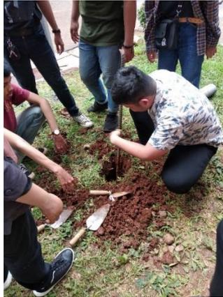
Gambar 5. Percobaan pembuatan lubang biopori dengan linggis
