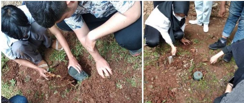
Gambar 6. Memasukkan pipa biopori ke lubang yang telah jadi dan dirapikan
