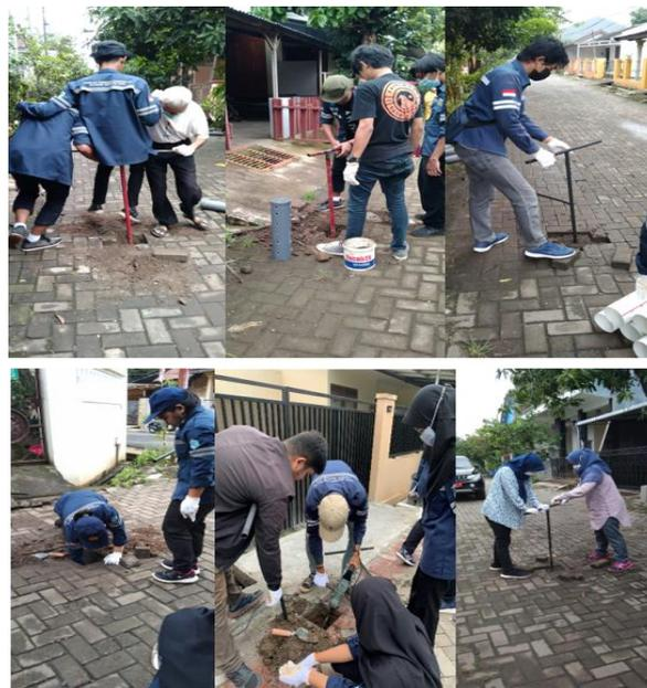
Gambar 10. Proses pembuatan lubang biopori dengan bor tangan
