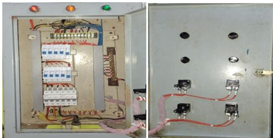
Gambar 13. Hasil perapihan dan perbaikan instalasi box panel
