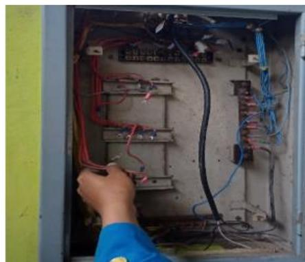
Gambar 11. Box panel sebelum perbaikan
