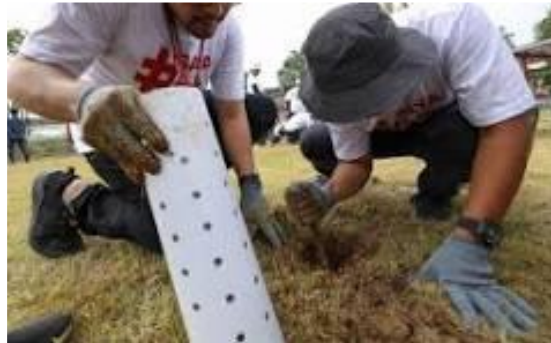
Gambar 7. Bapak-bapak membantu dalam pemasangan biopori
