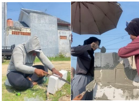
Gambar 1. Proses Pembangunan Incinerator Sederhana
