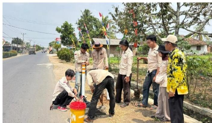
Gambar 1. Proses pemasangan reflektor jalan dan pengecoran pada titik rawan ruas perbatasan
