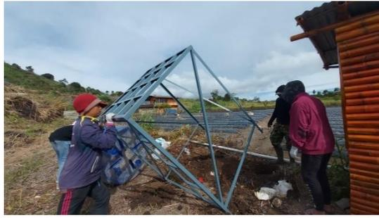
Gambar 17. Proses Pemasangan Menara Tendon Air
