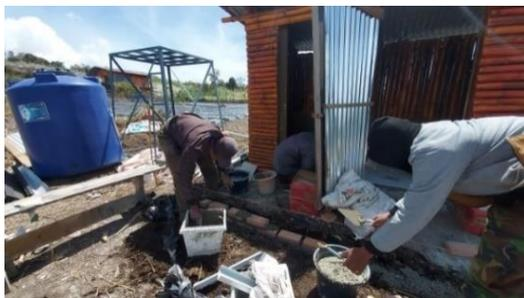
Gambar 13. Proses Pengecoran Teras Toilet
