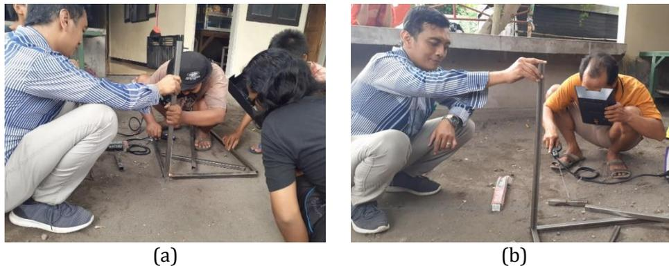
Gambar 8. Praktek pengelasan (a) membuat tack welding (b) Penyambungan keseluruhan
