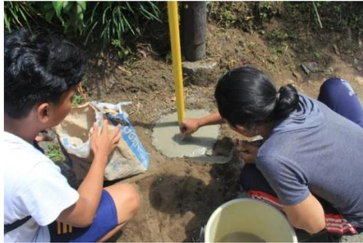
Gambar 5. Peletakkan dan Pengecoran Tiang Papan Nama Petunjuk Jalan
