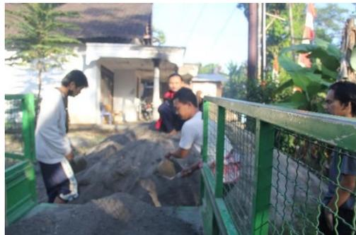
Gambar 3. Pengangkutan material untuk pondasi cor tiang papan petunjuk jalan
